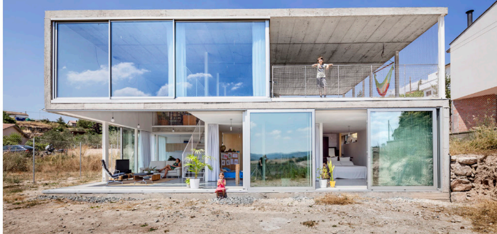
Una vivienda unifamiliar diseñada por el estudio Narch, con el 50 % de la envolvente acristalada y abierta al paisaje y construida con menos de 900 € el metro cuadrado, es la protagonista de "Low cost. smart architecture", documental realizado por Ibai Abad, de Mayo Films Foto: Adrià Coula
